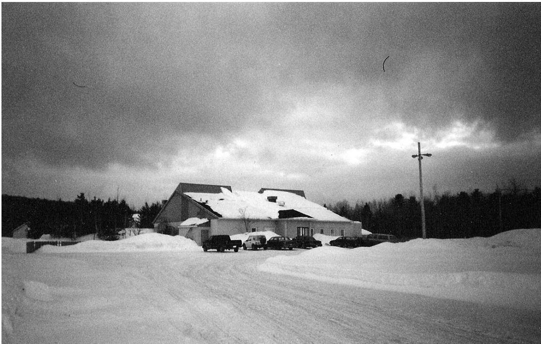
Le nouveau domicile de Waseskun à Saint-Alphonse-de-Rodriguez (vue de la grille d'entrée).
